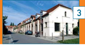
Im Sudhausweg wurden attraktive Büros geschaffen.
